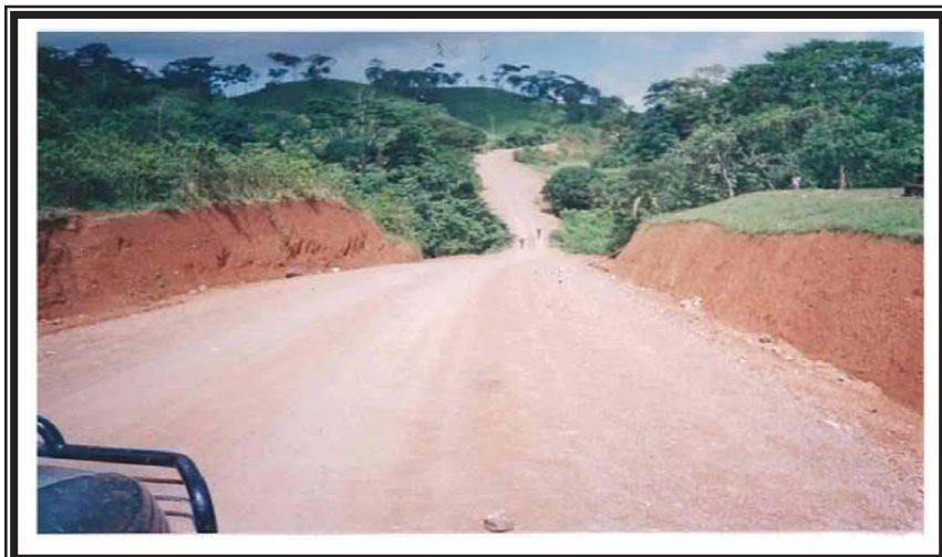
Vista parcial del acabado de la Superficie de Rodamiento del camino en el sector correspondiente a la Est. 517+300
