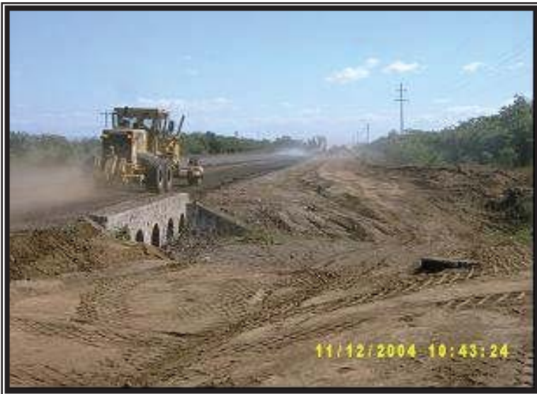
Proceso de terracería, banda derecha (Est. 162+500)
