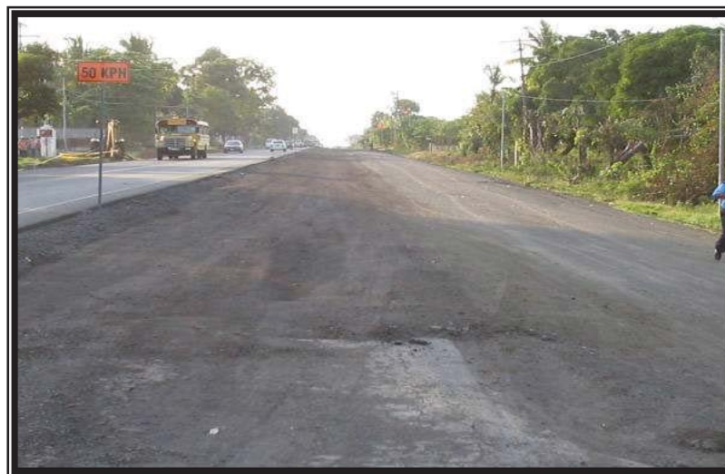
Colocación de sub base, banda izquierda (Est. 6+200)
