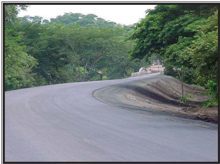
Acceso al Puente Lóvago
