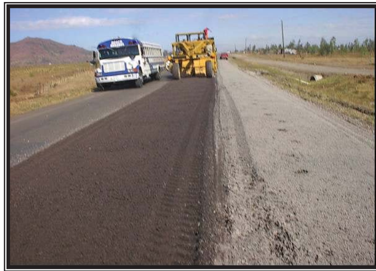
Trabajos de reciclado , banda derecha Est. 5+770
