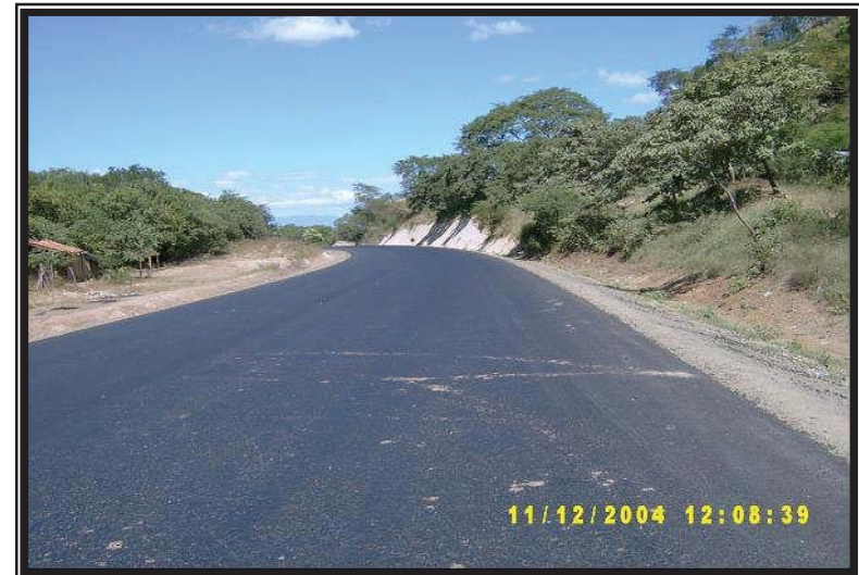
Colocación de base negra, sector de Israel (Est. 168+200)
