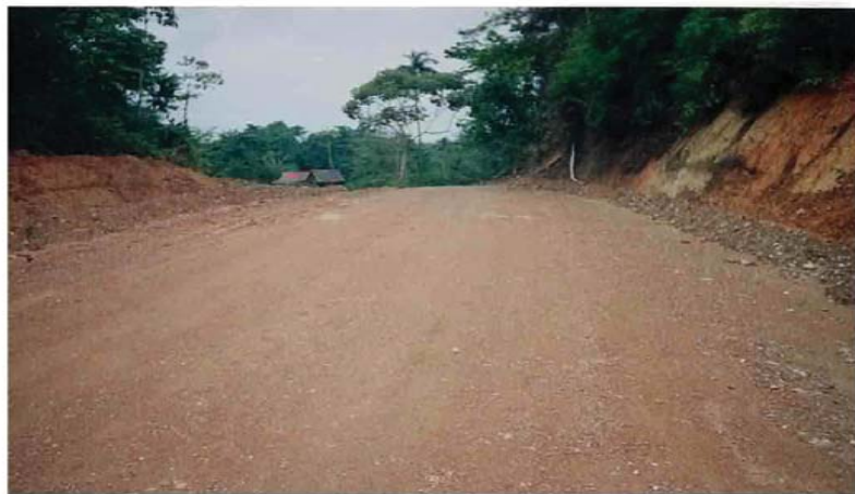
Parte de las reparaciones sobre la vía realizadas en el sector Santa Rosa, Estación 509+000.
