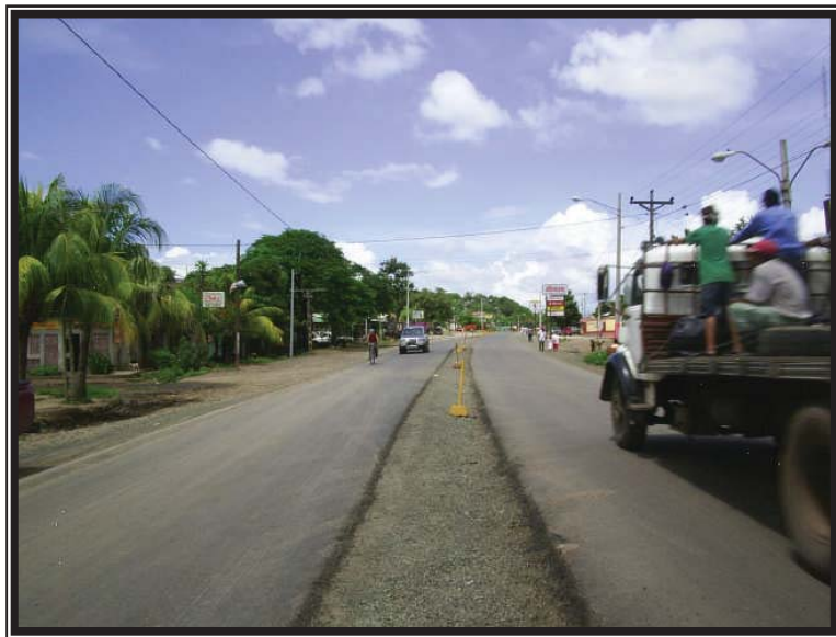
Carpeta Asfaltica Con Area Para Boulevard Est. 24+200
