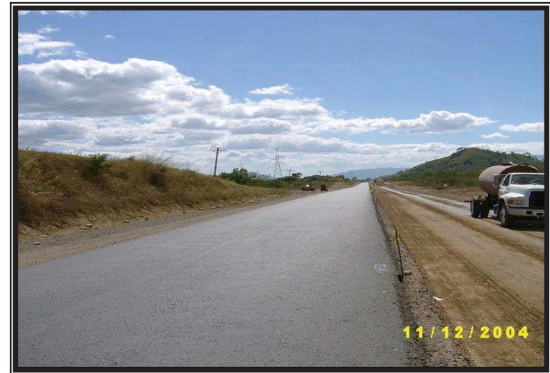
Preparación de terracería, banda derecha (Est. 189+660)
