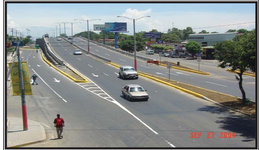
Intersección Portezuelo: Vista oeste Puente a Desnivel.
