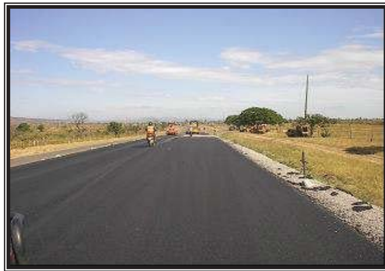
Carpeta asfáltica colocada Est. 0+700
