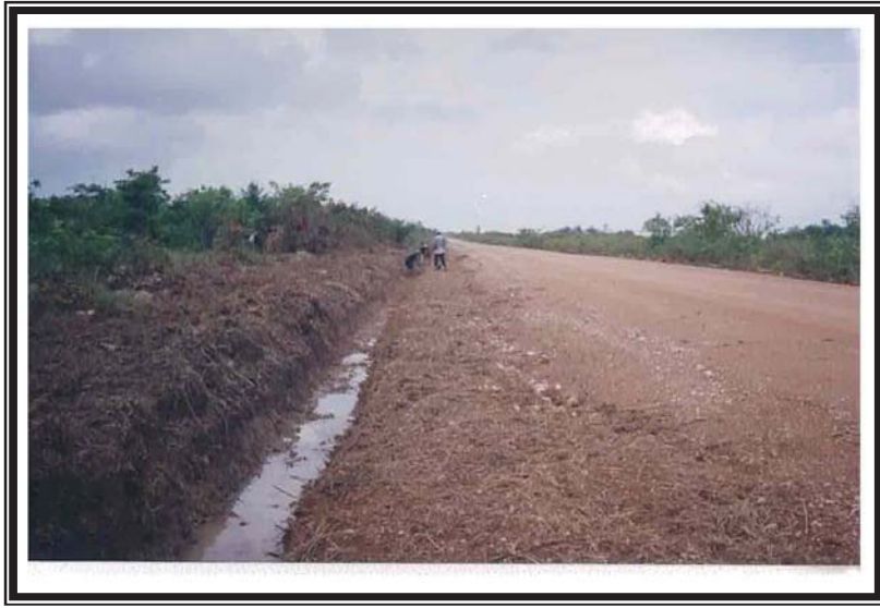
Construcción de Canales
