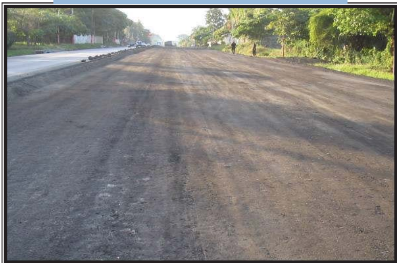
Sub base terminada, banda izquierda (Est. 6+000)
