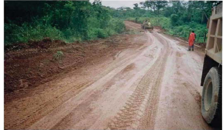
Equipo y Maquinaria de El Contratista SEMCO realizando labores de reparación de la superficie de rodamiento dañada por las lluvias en el sector Estación 511+500.
