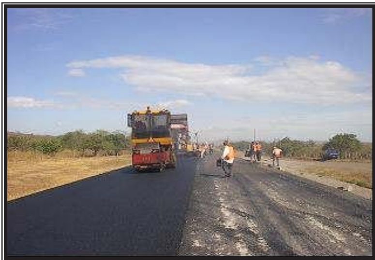
Colocación de carpeta asfáltica, banda izquierda Est. 5+770
