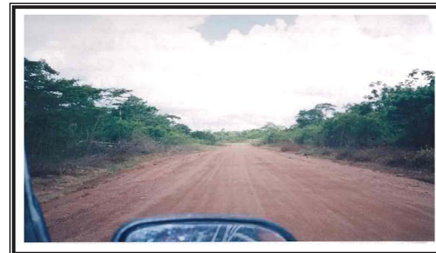
Vista general del camino en el sector, Est. 524+000, debidamente reparada la Superficie de Rodamiento con material del Banco de Préstamo “El Bellorín”
