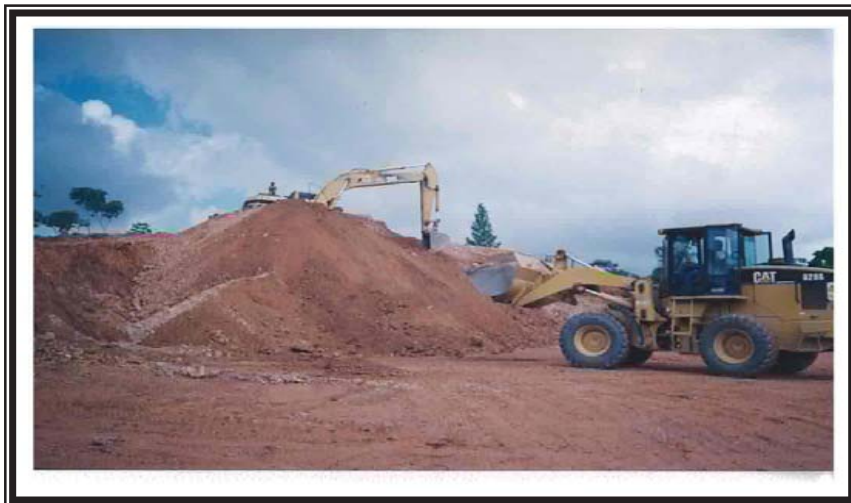
Equipo y Maquinaria de El Contratista en labores de acopio y cargue de material en el Banco de Préstamo Maniwatla, Est. 525+700
