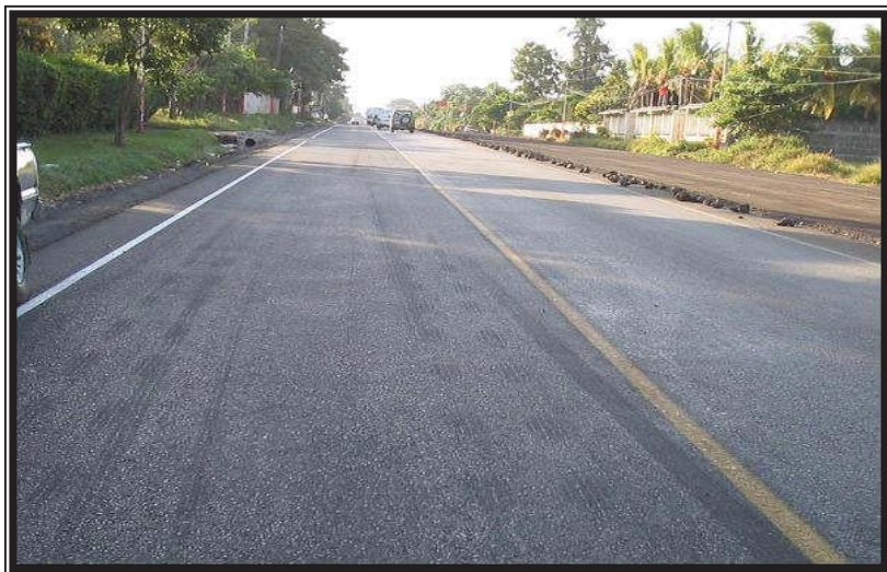
Colocación de carpeta asfáltica, banda derecha (Est. 6+200)
