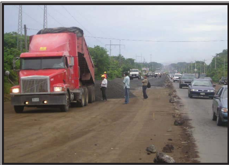
Acarreo de material de subbase triturada de la Est. 0+600.00 a la Est. 0+800.00, en banda derecha
