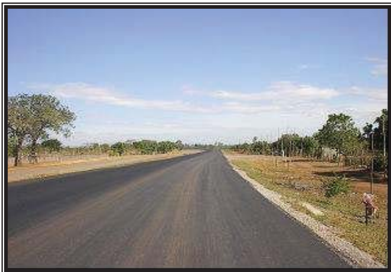
Carpeta asfáltica colocada Est. 0+400
