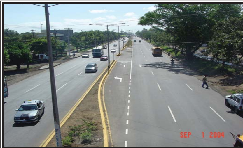
Km. 7 Carretera Norte (Sector Waspán) Proyecto finalizado incluyendo señalización vial.
