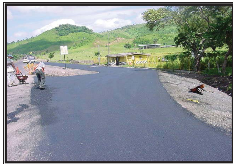
El Pavimento de Concreto Bituminoso en caliente est. 50+720
