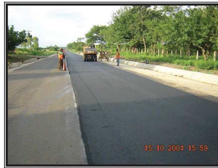
Segunda Capa en un banda en la Estación 7+300.
