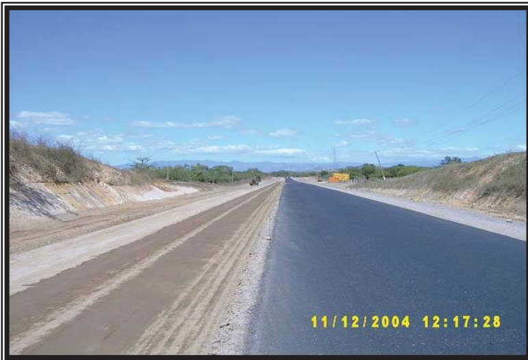
Colocación de base negra, banda derecha (Est. 184+400)
