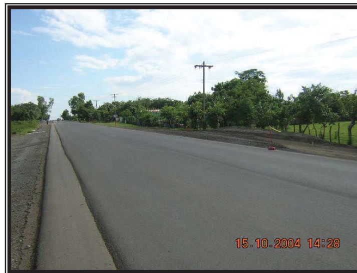
Primera y Segunda Capa de Carpeta Asfáltica bituminoso ya colocada en Estación 7+500
