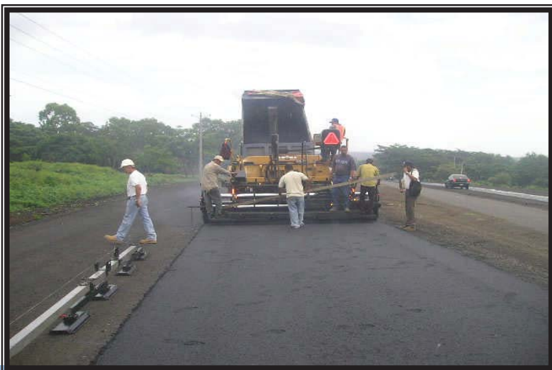
Colocación de 4cm de espesor de carpeta asfáltica en el retorno No. 4 ubicado en la est. 4+205.00 lado derecho
