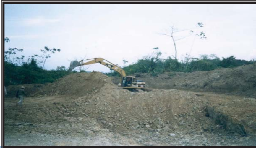
Equipo y Maquinaria de El Contratista ejecutando actividades de Excavación y acopio de material para terracería en el Banco de Préstamo “Casa Bonita”, Est.489+650
