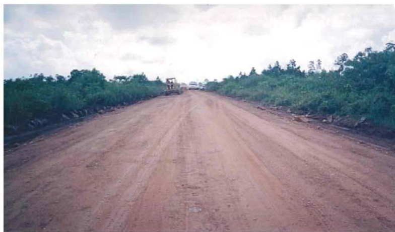
Obras de reparación y recubrimiento del camino en el sector comprendido en la Est. 524+200.
