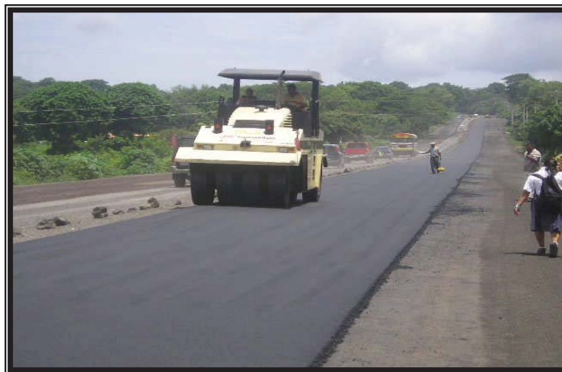
Compacción de capa asfáltica de la est. 3+600.00 a la est. 4+000.00 lado derecho
