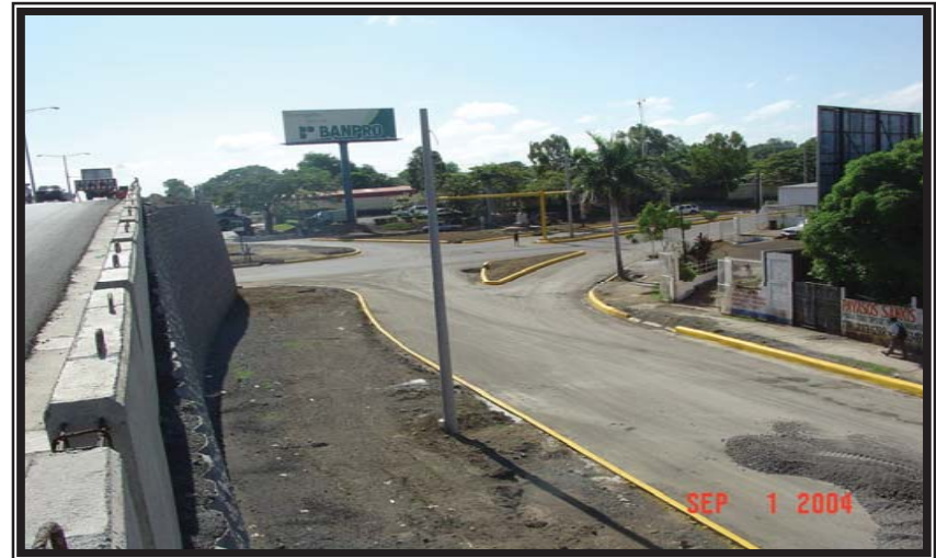
Intersección Portezuelo: Vista Sur al puente desnivel, el acceso por la que incluye la marginal.
