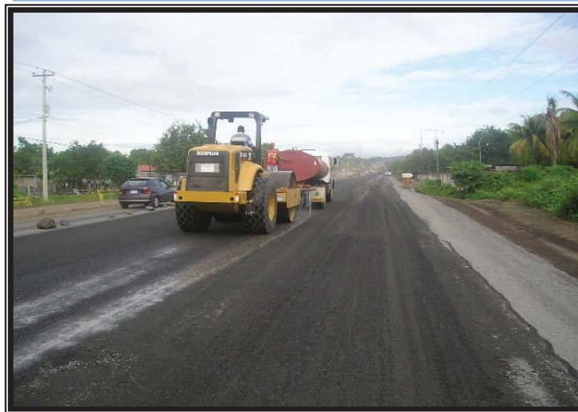
Proceso y compactación de material de base triturada de la Est. 0+900.00 a la Est. 1+320.00, banda derecha
