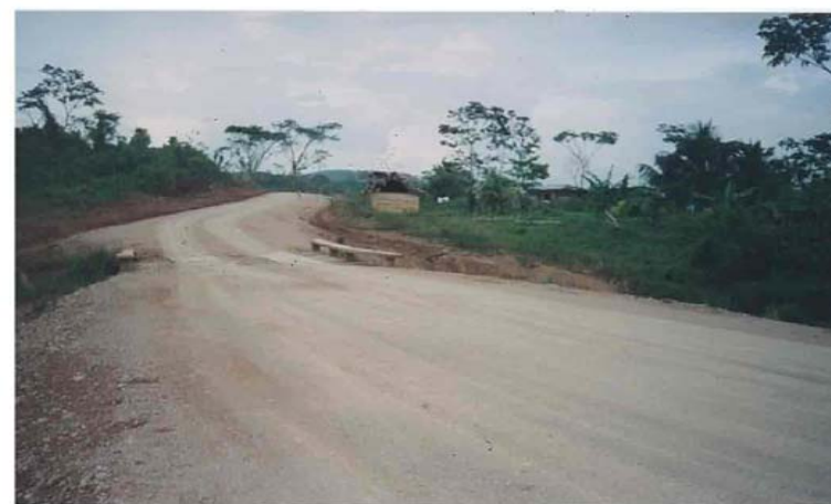
Superficie de Rodamiento debidamente acabada a partir del recubrimiento de la misma, Est. 502+800
